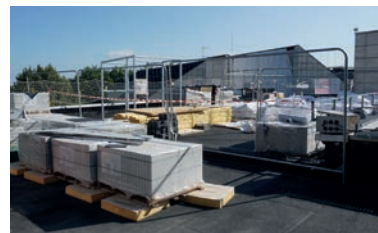
▲ Rénovation de la toiture de l'Hôtel de Ville
